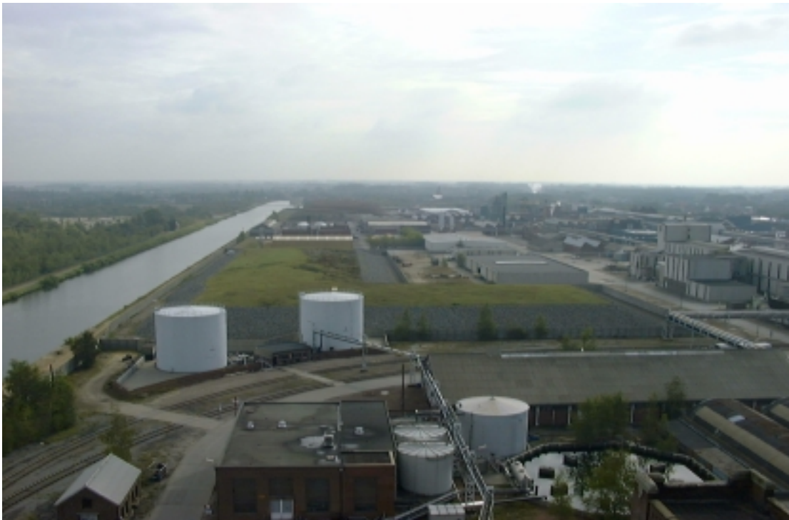
Fig.2. Luchtfoto van UMTRAP
