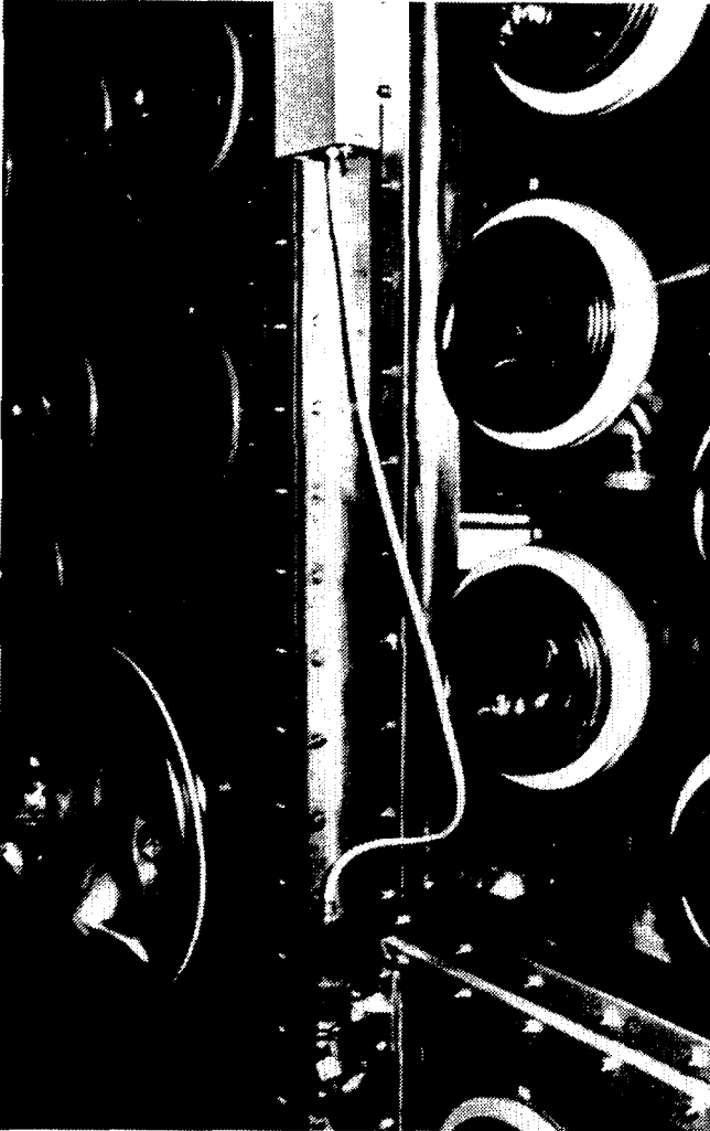
Figure 3 : Monitoring continu d'air (détecteur semi-conducteur et son analyseur d'impulsions mono-canal)
